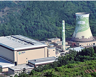
云南大理垃圾发电厂(1200吨/天) 三峰集团供图
