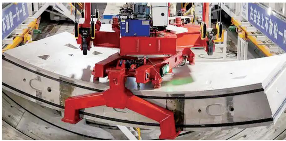
在上海沪渝蓉高铁崇太长江隧道施工现场，“领航号”盾构机进行管片吊装作业。 新华社发
