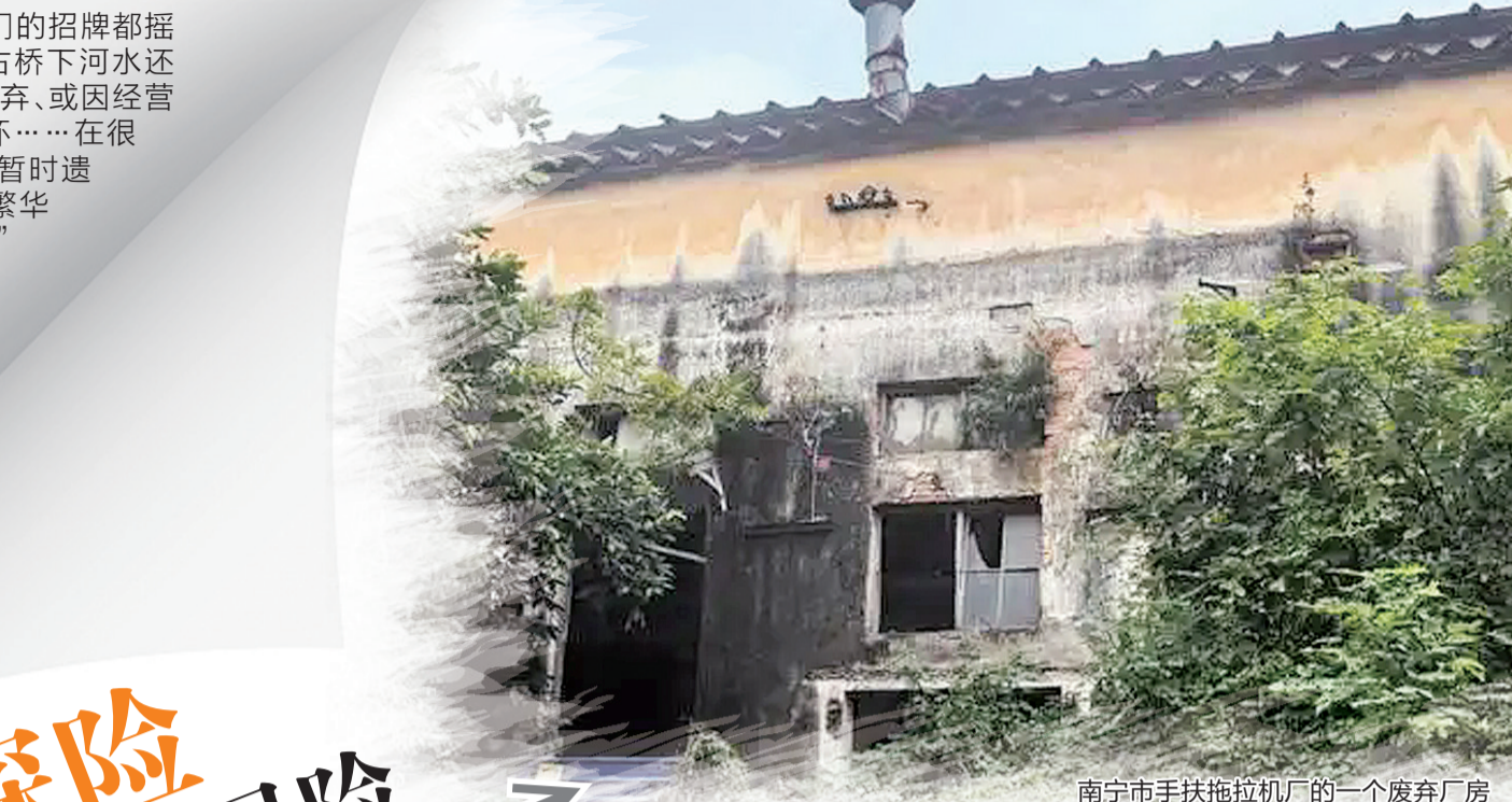
南宁市手扶拖拉机厂的一个废弃厂房
